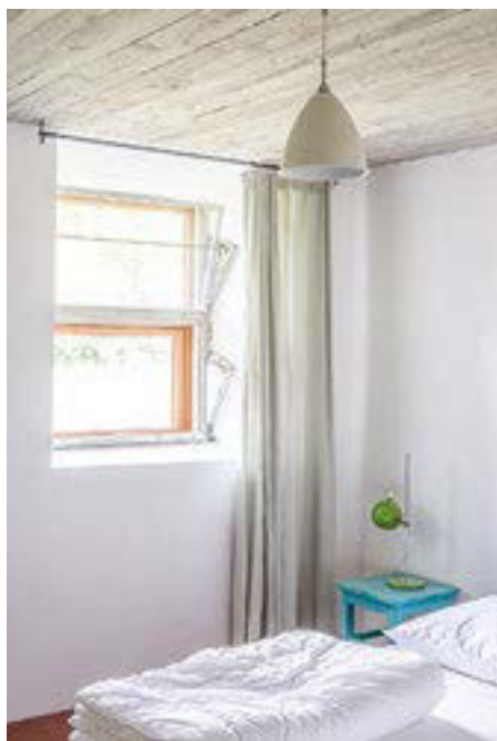
Die alten Zargen der Stallfenster wurden mit neuen Verglasungen ergänzt.
