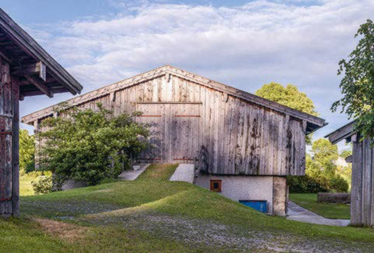
Die geschlossen ver- bretterte Wetterseite mit der Tennenbrücke.
