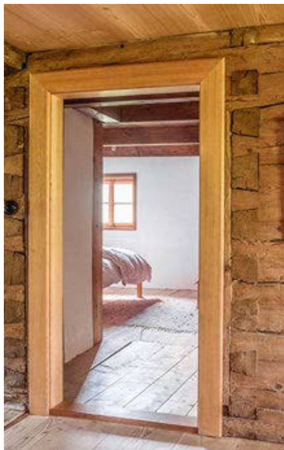
Stamm auf Stamm gelegt und über die Ecken verzahnt. Detailblicke auf das Holzstrickwerk der dicken Innenwände.
