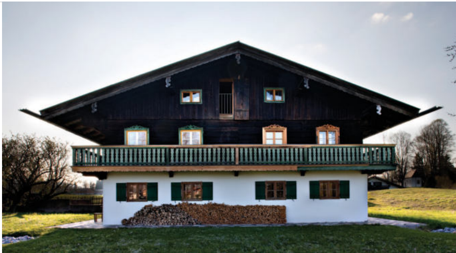
BAUERNHOF „BEIM STADLER“ Sanierung, Gmund
